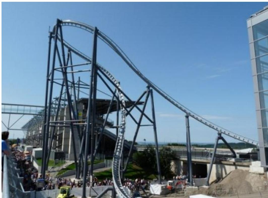
Расположенный в парке Нюрбургринг в Германии, аттракцион Ring Racer впервые открыл свои двери для публики в 2009 году. Уникальная система подачи сжатого воздуха способна разгонять кабинки до скорости 217 км/ч, но в целях безопасности посетителей, порог был опущен до 159 км/ч. Горки сконструированы таким образом, что маршрут проходит почти параллельно гоночной трассе, предлагая посетителям возможность ощутить себя настоящими гонщиками.
